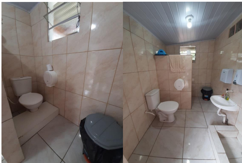
BANHEIRO COM RAMPA DE ACESSO PARA USO DAS CRIANÇAS
