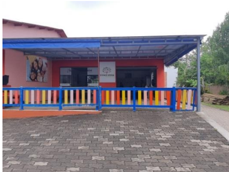
FACHADA DO PRÉDIO
