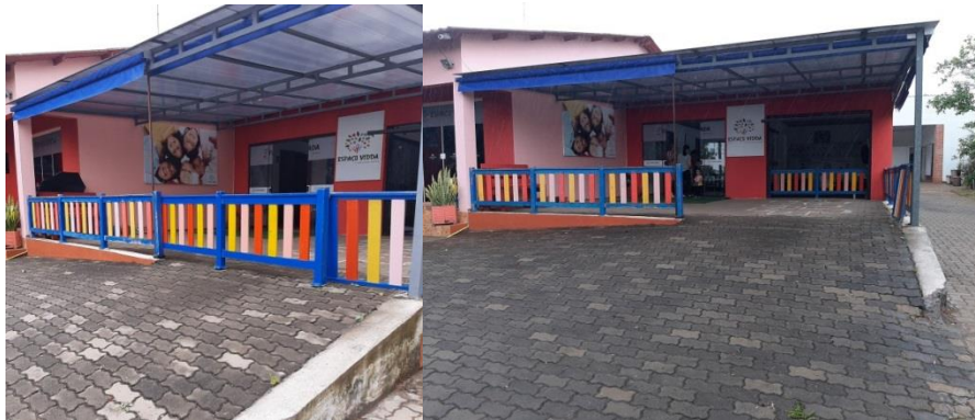
RAMPA DE ACESSO ENTRADA DA ÁREA COBERTA
